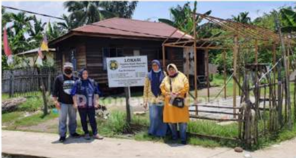
Foto : Pembangunan dan pemasangan plank rumah kaca, program PKM USU di Desa Perlis
